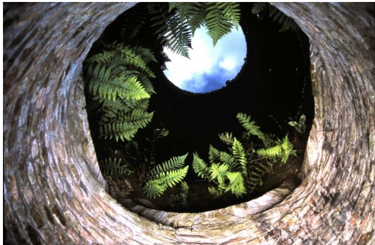
Muurvarens in waterput Prinsenhof
