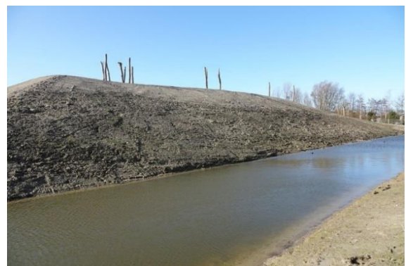
Het Waelbos gekapt, afgedekt met plastic en grond erover, is dat een oplossing voor vervuiling?
