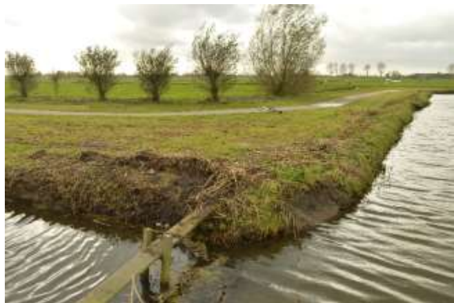
Figuur 28: Loopplank rechterzijde Ecopassage A13 (West kant) - T.L.E.Ottenhof
