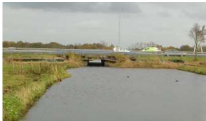
Figuur 29: Begeleiding rondom de Ecopassage A13 (West kant) T.L.E.Ottenhof
