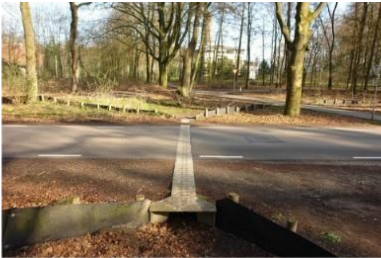
Figuur 6. Amfibieëntunnel en geleidingsschermen aan de Horalaan in Ede. Foto: F. Ottburg.
